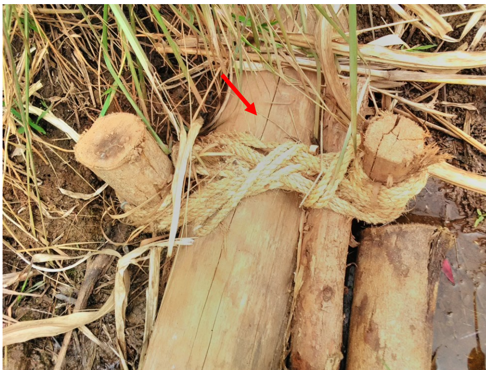
Figura 7 – Integridade do sisal no trecho 6.
